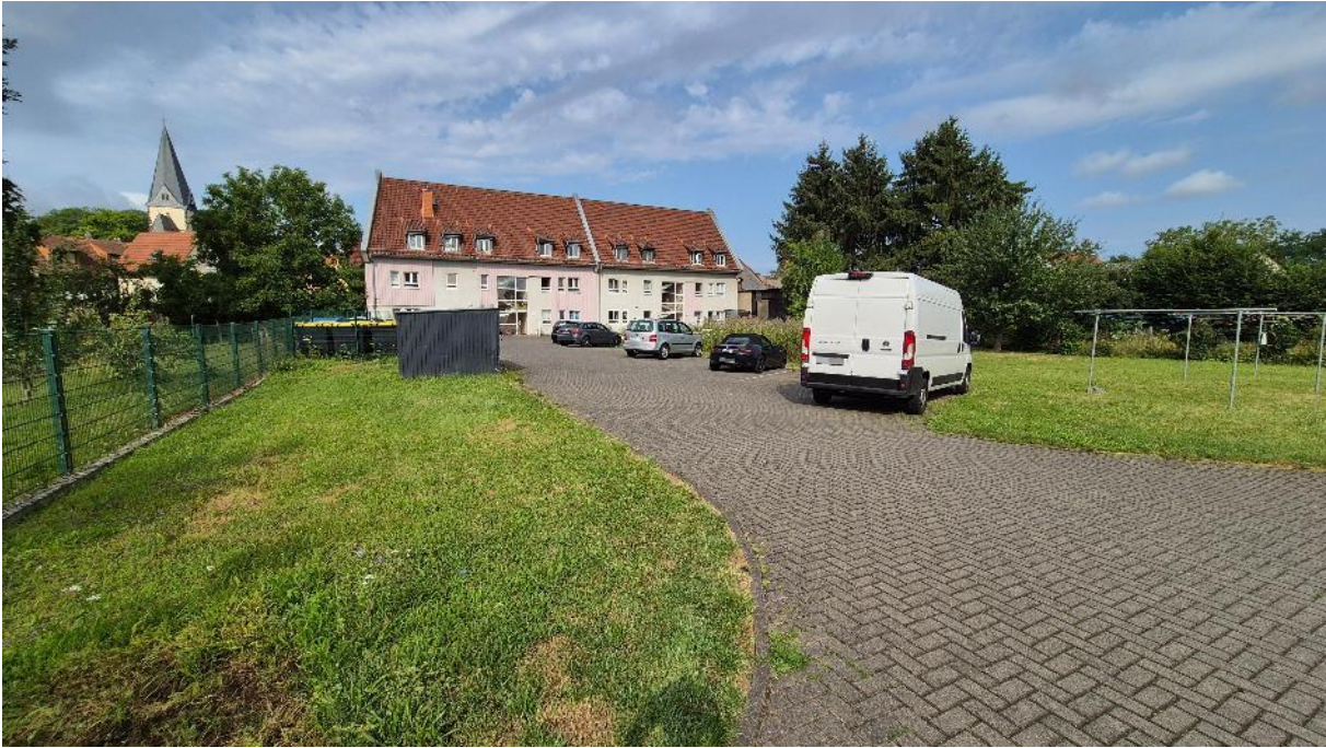
Abb. 11: Blick auf das Plangebiet vom Dammweg
