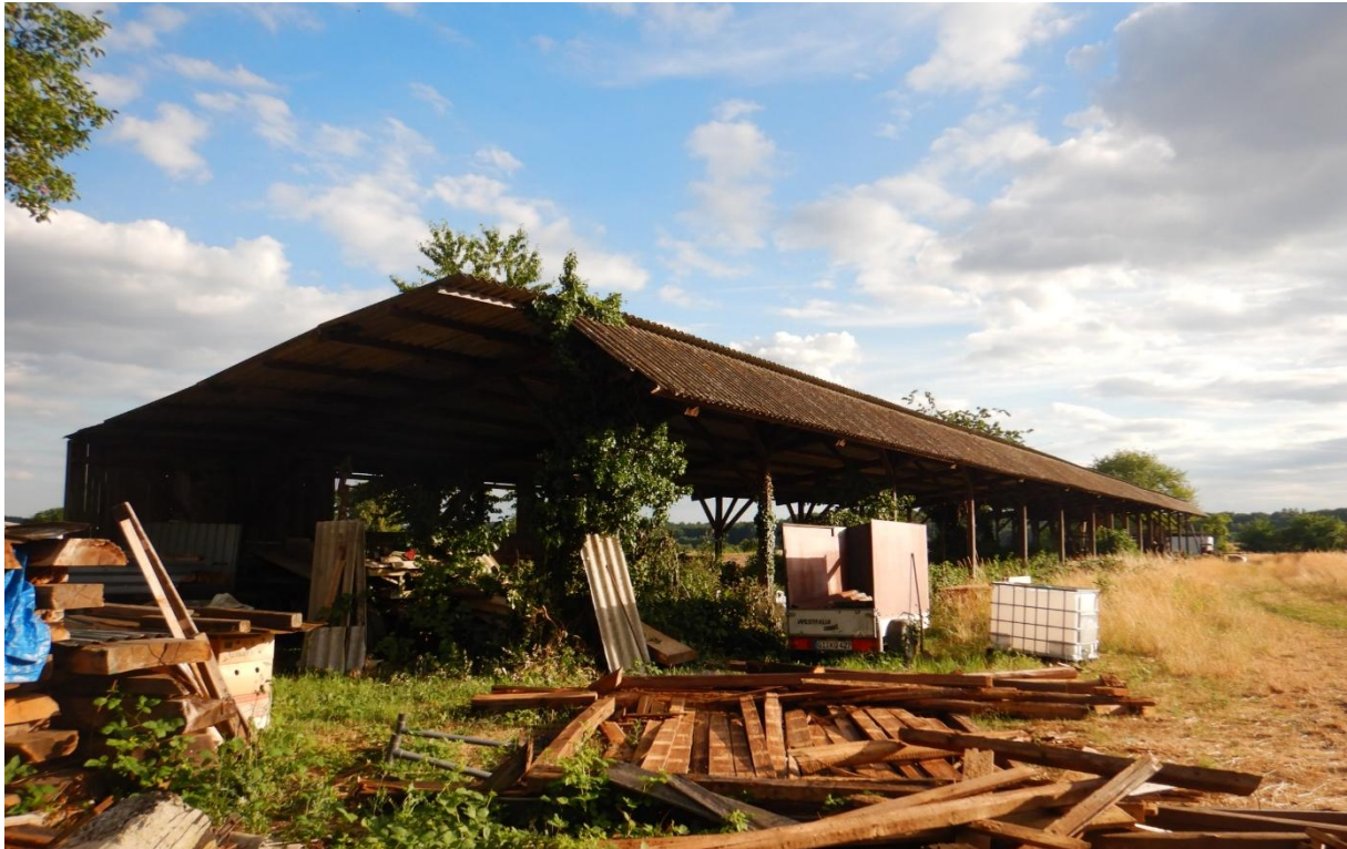
Abb. 20 Vorhandene Lagerhalle am südöstlichen Rand des Plangebiets.
