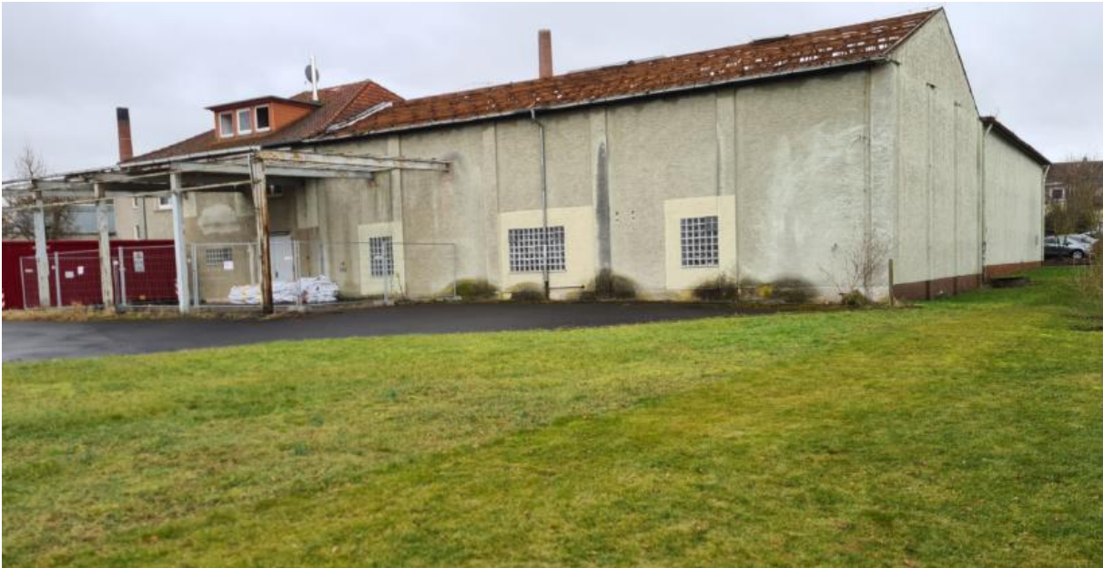
Abb. 24: Im Rückbau befindlicher Gebäudekomplex von Norden aus gesehen Quelle: Planungsbüro Vollhardt
