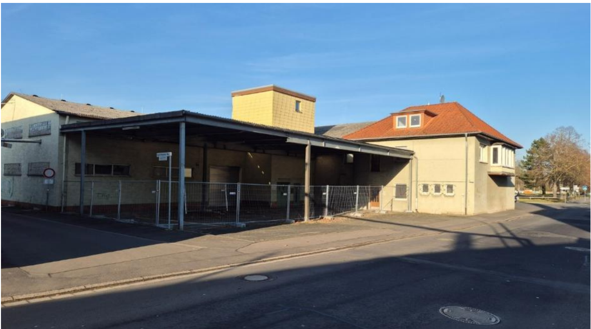
Abb. 11: Leerstehender Gewerbebetrieb im südöstlichen Teilbereich des Plangebiets Quelle: Planergruppe ROB
