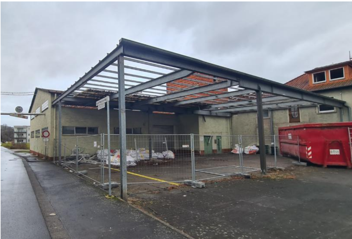
Abb. 25: Im Rückbau befindlicher Gebäudekomplex von Süden aus gesehen Quelle: Planungsbüro Vollhardt
