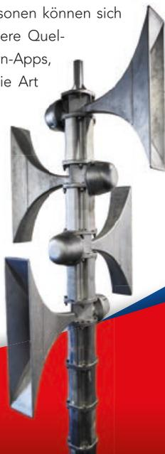
umstellt. Damit können großflächige Sirenenalarmierungen innerhalb von 1-2 Sekunden ausgelöst werden. Erstmals ist auch eine Echtzeit-Überwachung der Funktionsfähigkeit einer Sirene möglich.
